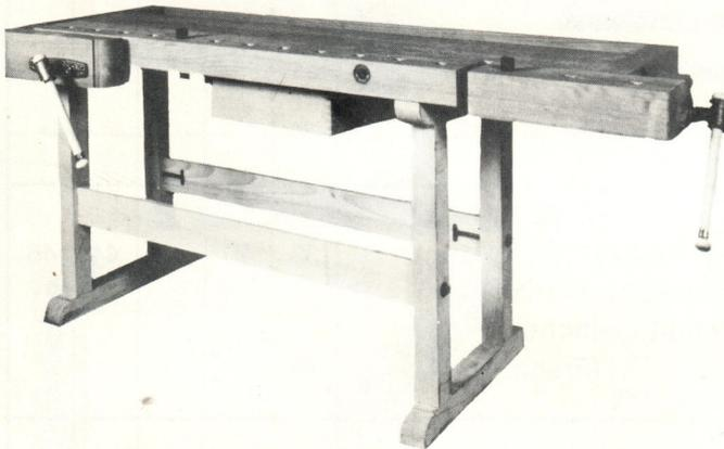
Hobelbank, mittelschwere Ausführung, mit französischer Vorderzange, Stahlspindeln, gußeiserner Parallelführung in der Vorderzange und Eisenführung in der Hinterzange.
